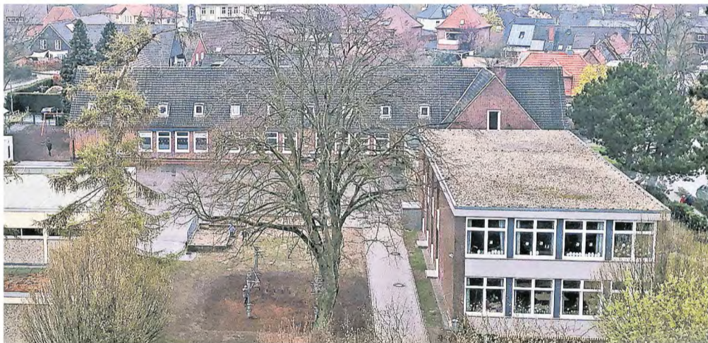
Sowohl der alte Querriegel der Hilgenbergschule (M.) sowie der Gebäudeteil aus den 1950er-Jahren (r.) sollen nach den Vorstellungen von Twoo Architekten abgerissen werden. Von der alten Hilgenbergschule bliebe allein die Turnhalle (l.) übrig.
